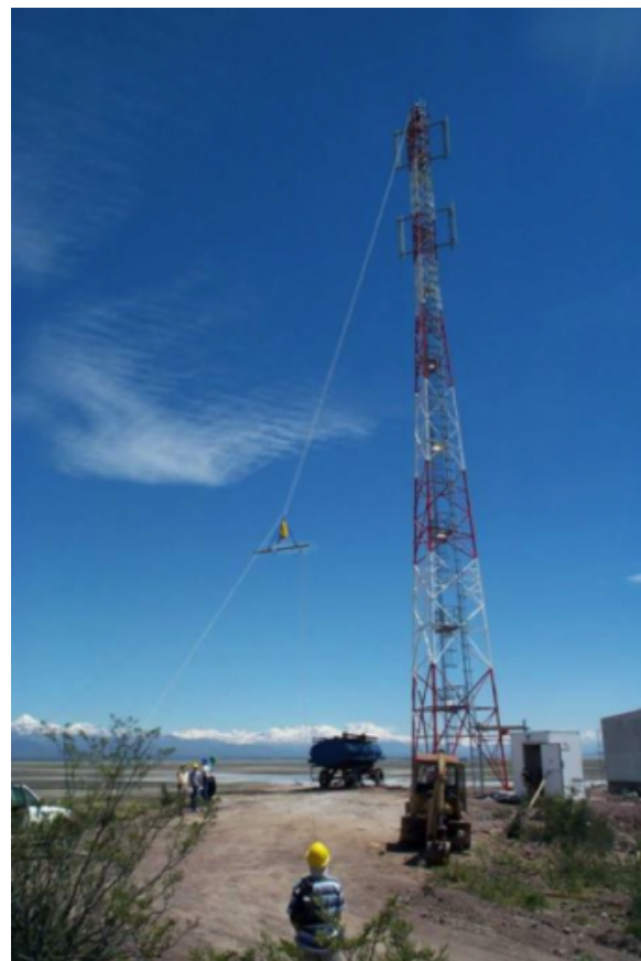
AUGER : Une des 4 tours de communication
